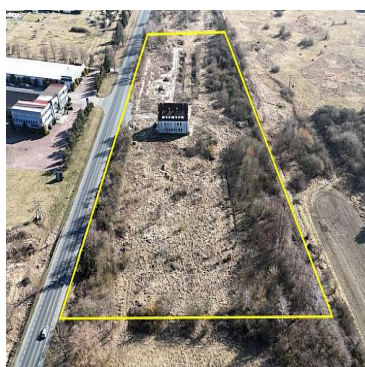
Budynek jest obecnie rozbierany. Usunięte zostaną także wszelkie pozostałości po zabudowaniach i instalacjach pomocniczych.
