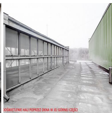
OŚWIETLENIE HALI POPRZEC OKNA W JEJ GÓRNEJ CZĘŚCI
