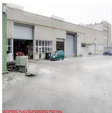
DOSTĘPNOŚĆ PLACU BEZPOŚREDNIO PRZY HALI
